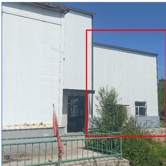
新增 100t/h 处理系统车间外部
