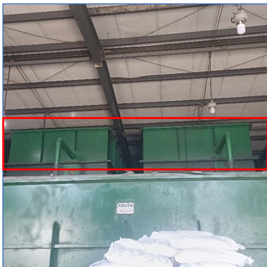
2 台斜管沉淀池顶部增高 1m
