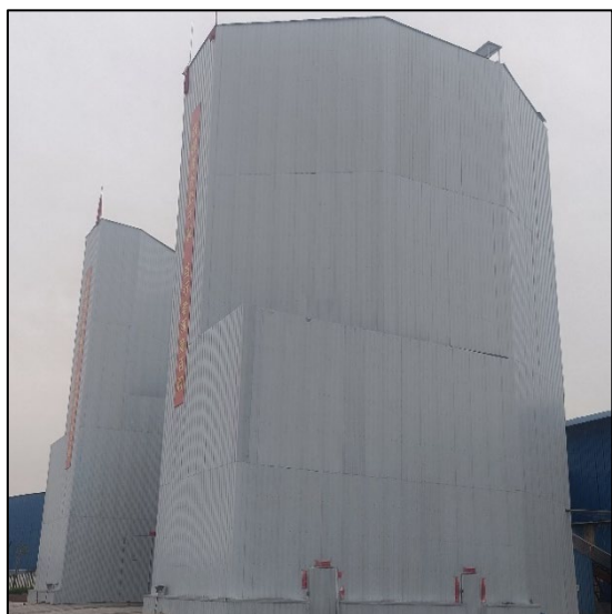
全封闭搅拌楼
