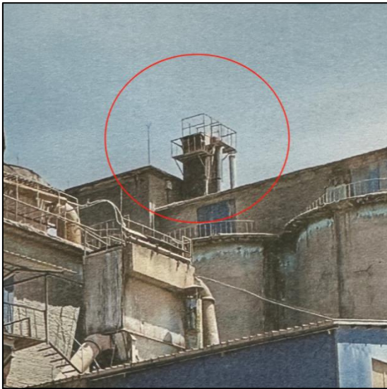
包装系统除尘设施及 DA007
