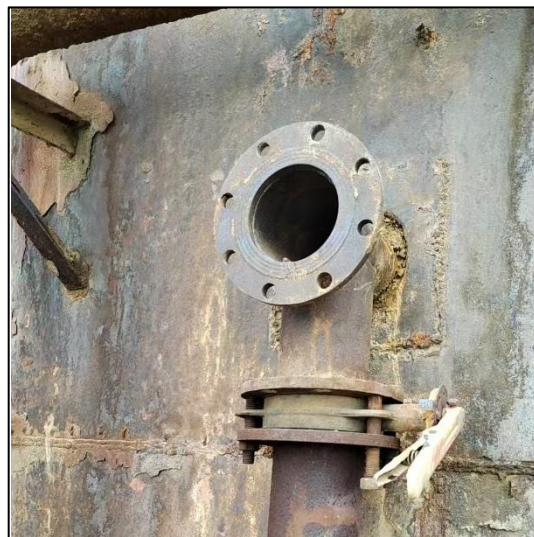
燃烧嘴及气管拆除
