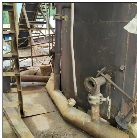
燃烧嘴及气管拆除
