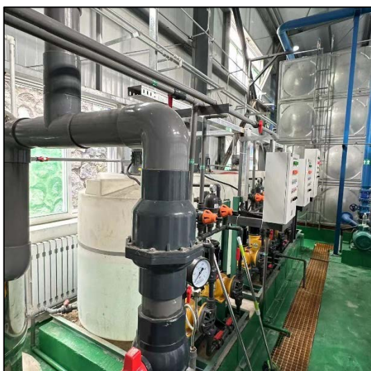
项目水处理系统药剂配置设备
