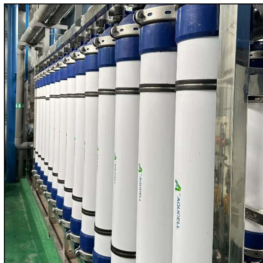
项目水处理系统超滤设备
